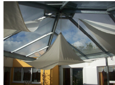
1c: Innenhofüberdachung mit Glaskuppel
