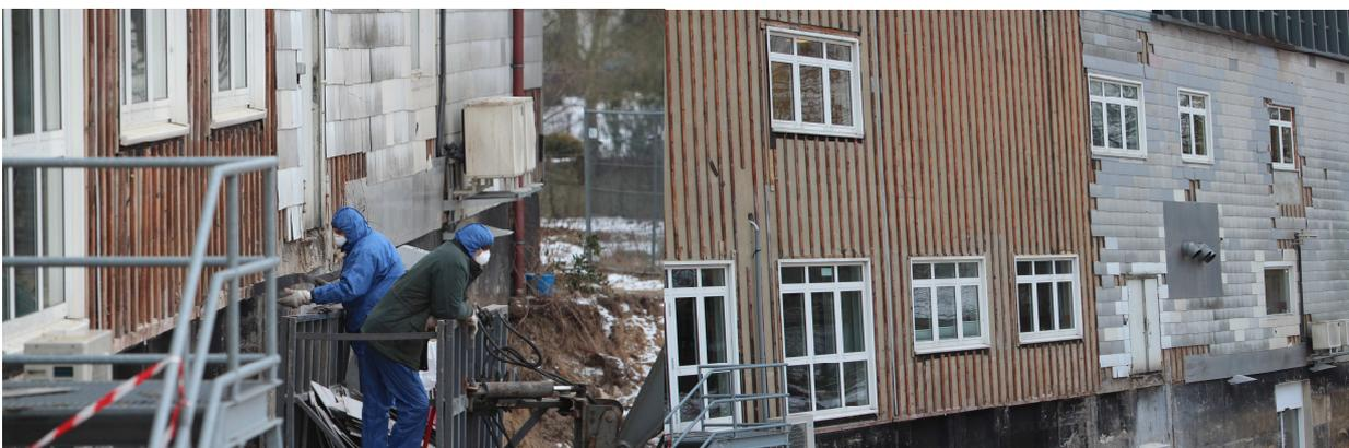
**Abb. 1.6** Arbeiter mit Schutzkleidung und Atemmaske bei der Sanierung und Entsorgung asbesthaltiger Fassadenverkleidung der Asklepios Klinik Harburg am 07.02.2012 (festgebundener Asbest; nur geringe Sicherheitsvorkehrungen notwendig)
