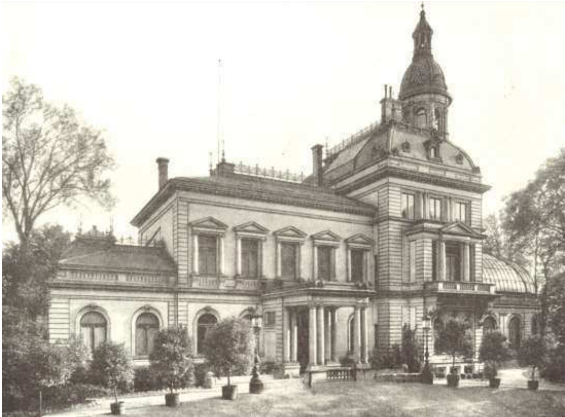
Abb. 56a: Villa Messtorff in Bergedorf, vordere Ansicht 1914.
