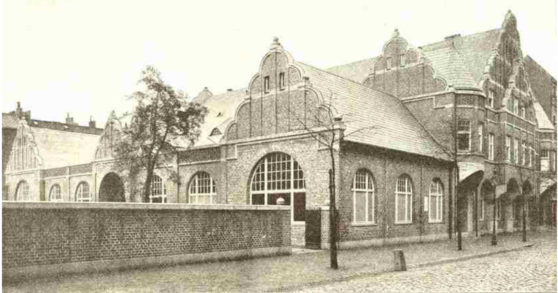
Abb. 66a: Gemeindehaus Außenansicht.
