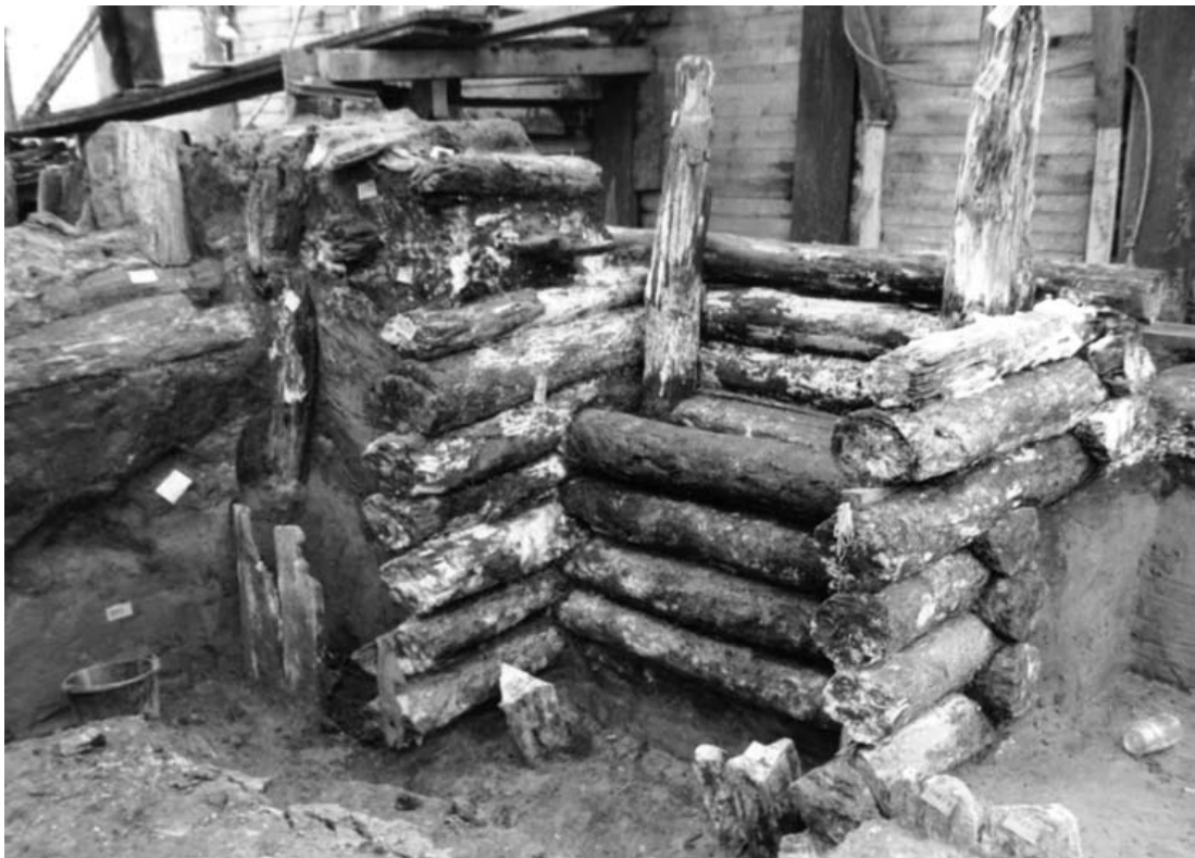
Abb. 66 Hansestadt Lübeck, Alfstraße-Fischstraße-Schüsselbuden. Alfstraße 11, Siedlungsperiode IV, Haus 16, Pfostenpaare der Blockbaukonstruktion, von Nordosten (Neg.-Nr. 18359).
