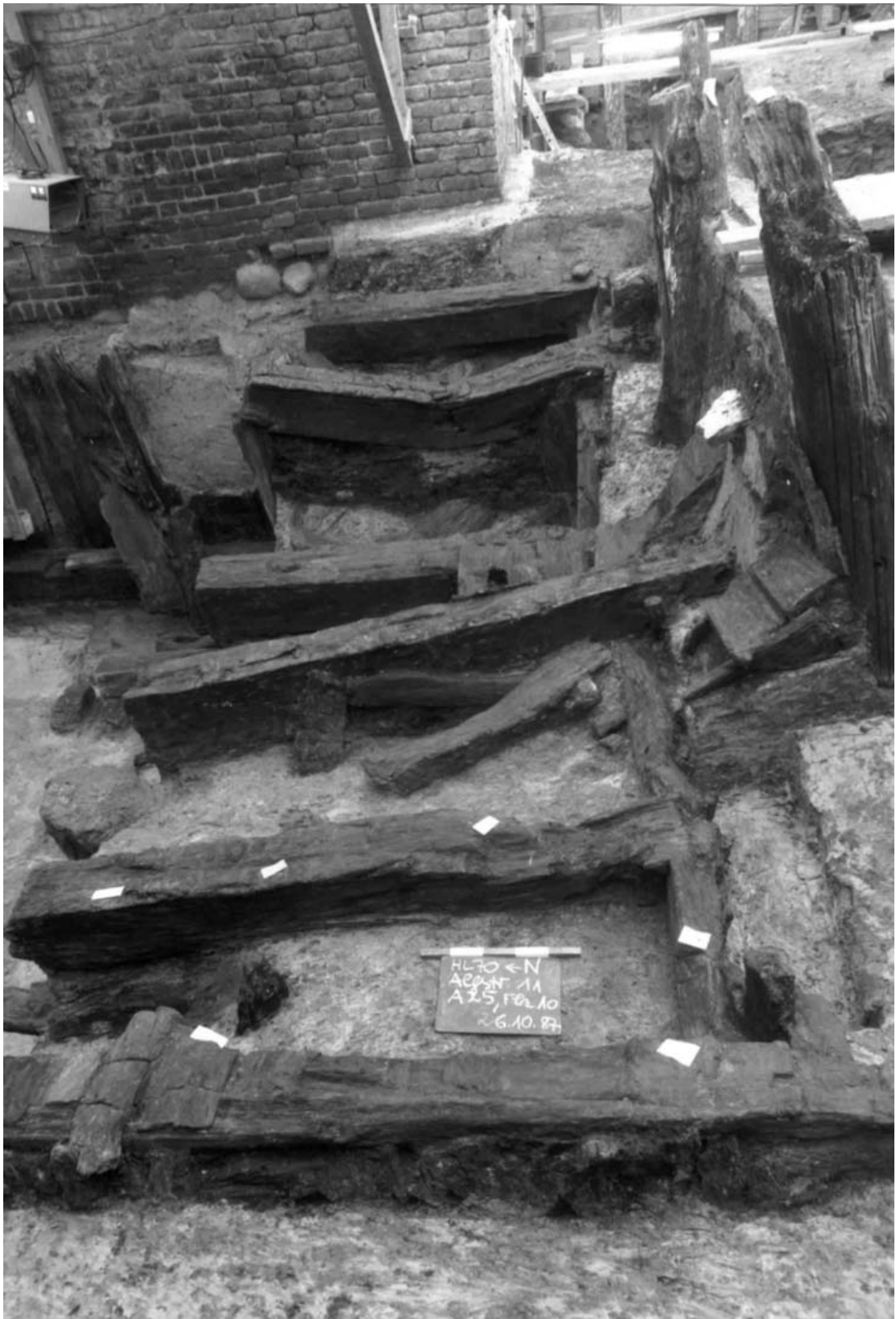
Abb. 61 Hansestadt Lübeck, Alfstraße-Fischstraße-Schüsselbuden. Alfstraße 11, Siedlungsperiode IV, Haus 15, Südhälfte der Kellerkonstruktion mit ausragenden Deckenbalken und Überresten der Lichtschächte, von Westen (Neg.-Nr. 17453).
