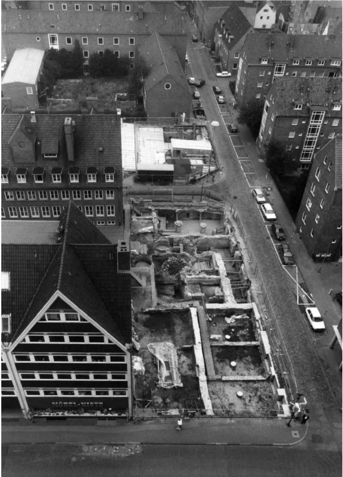
Abb. 9 Hansestadt Lübeck, Alfstraße-Fischstraße-Schüsselbuden. Schüsselbuden 6-8/Alfstraße 1-5. Ostteil des Grabungsgeländes mit den freigelegten Mauerkronen der 1942 zerstörten Bebauung, von Osten (Neg.-Nr. 17352).
