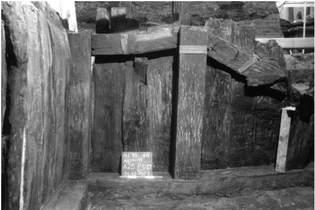
Abb. 60 Hansestadt Lübeck, Alfstraße-Fischstraße-Schüsselbuden. Alfstraße 11, Siedlungsperiode IV, Haus 15, Südostecke der Kellerkonstruktion mit Schwellbalken, Wandständern, Rähm und Wandbohlen, von Norden (Neg.-Nr. 17589).
