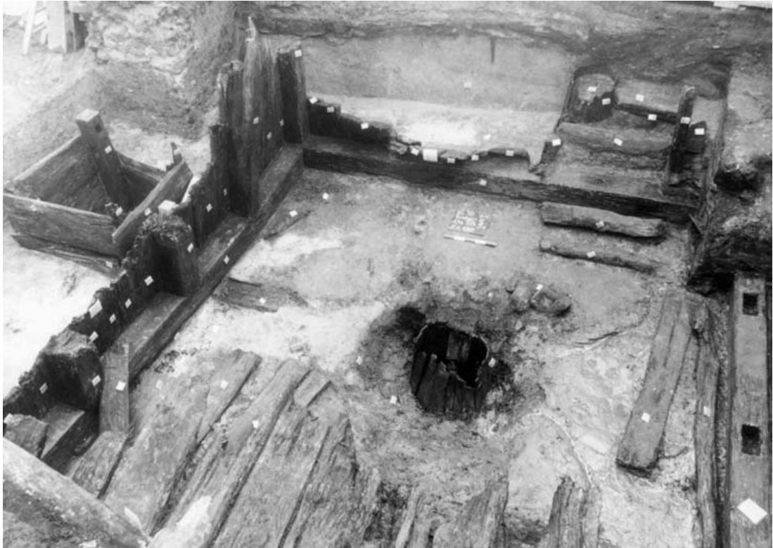
Abb. 44 Hansestadt Lübeck, Alfstraße-Fischstraße-Schüsselbuden. Fischstraße 12, Siedlungsperiode IV, Haus 8, Überreste der in situ erfaßten Kellerwände, vorne in den Kellerraum verkippte Wandbohlen, hinten rechts südliche Kellertreppe mit eingesenktem Daubenfaß, links Brunnen 3 mit "Drainagerinne", mittig Brunnen 4, von Norden (Neg.-Nr. 17617).
