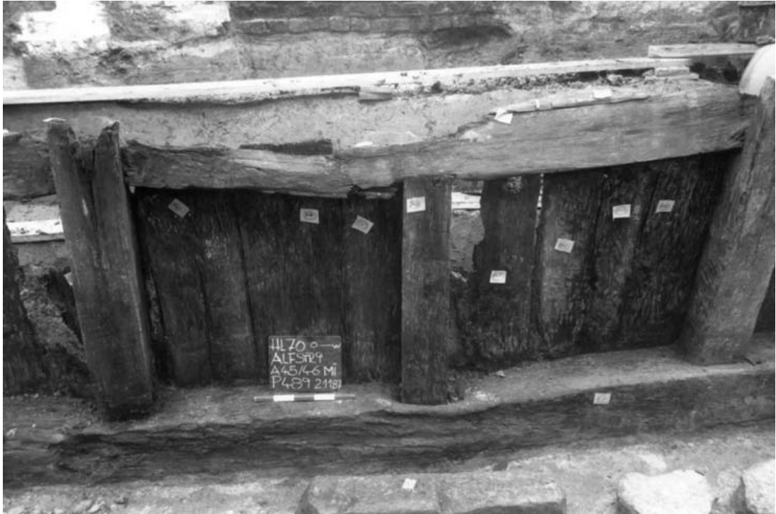
Abb. 74 Hansestadt Lübeck, Alfstraße-Fischstraße-Schüsselbuden. Alfstraße 7-9, Siedlungsperiode IV, Haus 18, Südwand der Kellerkonstruktion mit Schwellbalken, Wandständern, Rähm und Wandbohlen, von Norden (Neg.-Nr. 17473).
