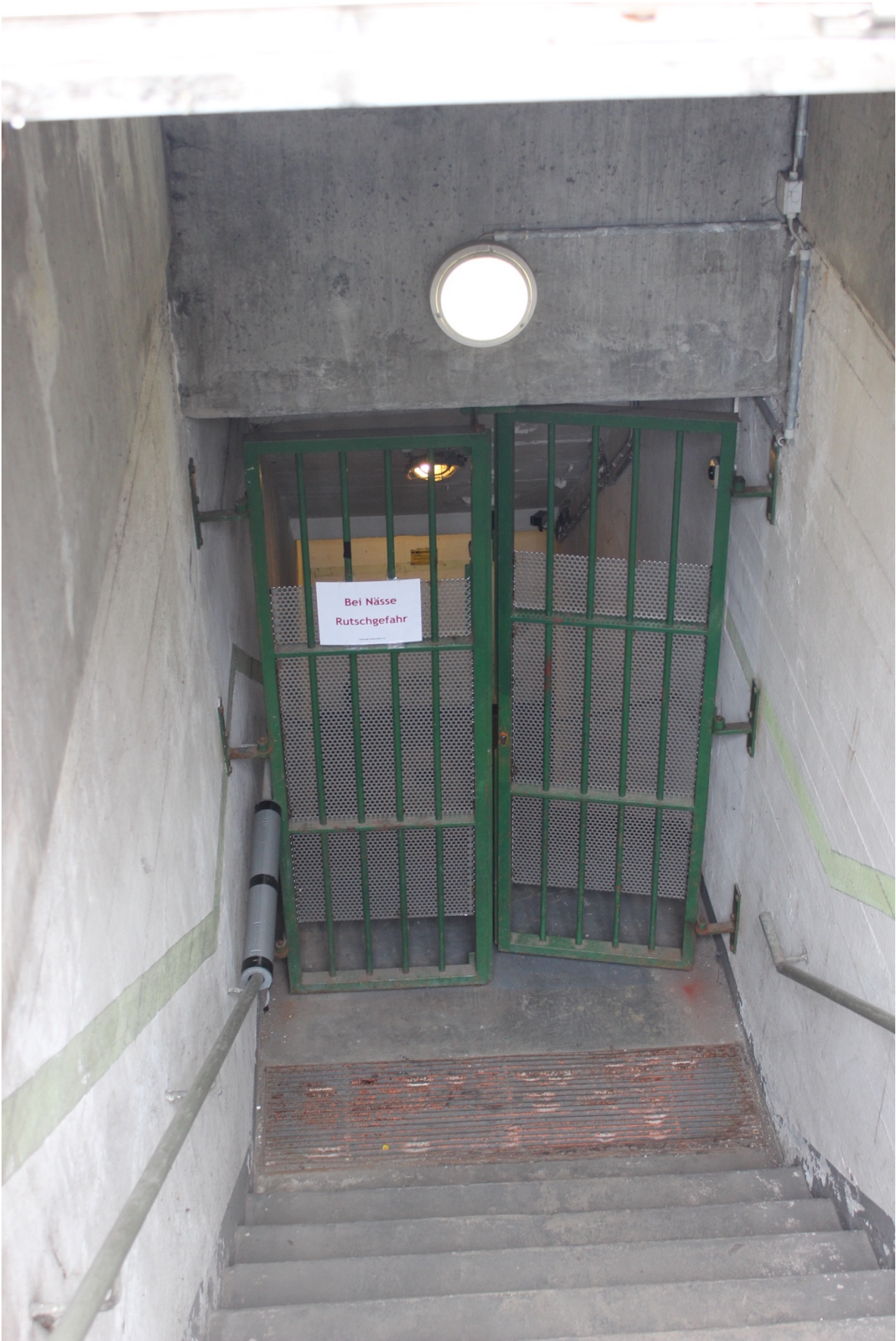
Abbildung 22: Bunker am Steintorwall, Eingang
