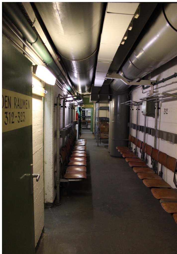
Abbildung 23: Bunker am Steintorwall
