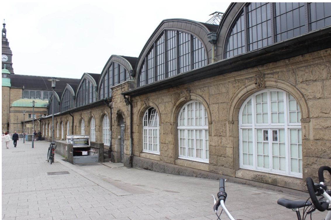
Abbildung 21: Bunker am Steintorwall, Eingang
