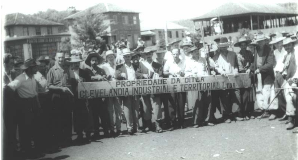
Abb. 9: Aufstand der Kolonisten. Nach der Zerstörung des Gebäudes der Siedlungsgesellschaft.
