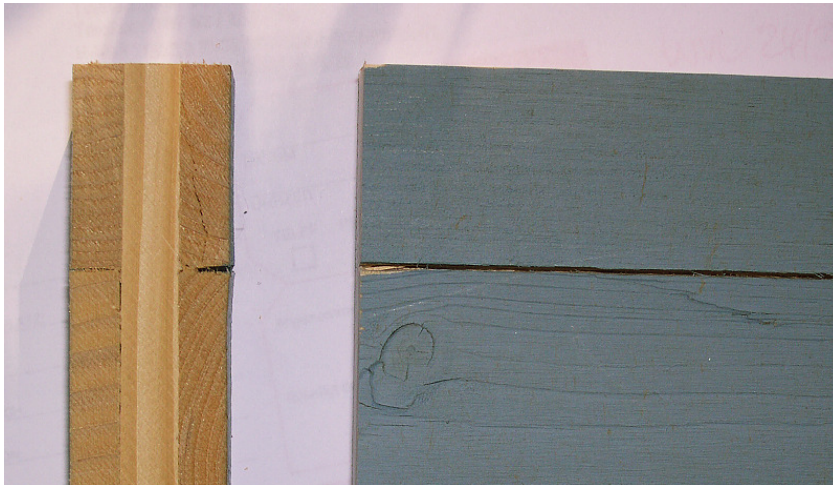
Abbildung 15 Detailaufnahmen einer bewitterten mehrschichtigen Fassadenplatte (einseitig mit einer Wetterschutzlasur beschichtet), Problemzonen: offene Fugen im Bereich der Schmalflächenverleimung der Deckschichtlamellen und der Verklebung zur Mittellage
