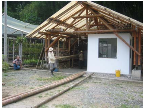
Abb. 5.92: Vorbereitung der Guaduahalme für die konventionelle Trocknung
