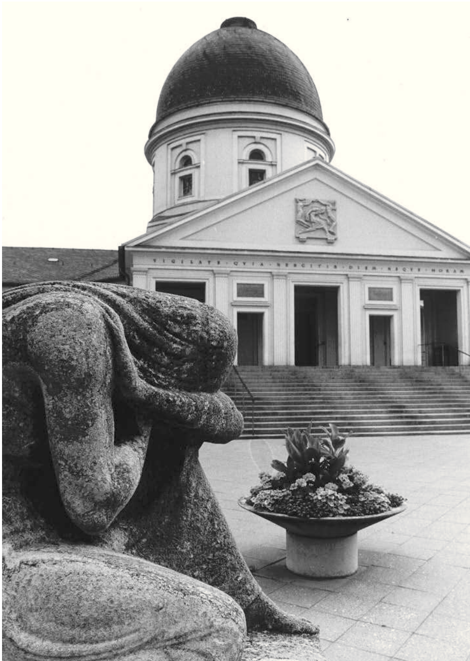
Abb. 155 b: Im Bild unten: Krematorium Wilmersdorf, erbaut 1919-1922 vom städtischen Baurat Otto Herrenring. Vorne links: eine von insgesamt vier Statuen „Die Trauernden“ von Eberhard Encke
