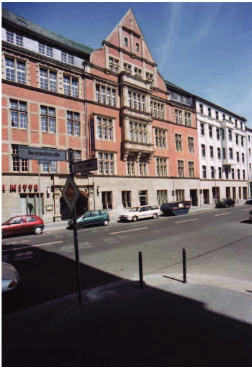
Abb. 98: Denkmalgeschützte Klinkerfassade mit Sandsteingewänden der Häuser Reinhardtstraße 14-16, Putzfassade des Hauses Reinhardtstraße 12, Bauzeichnung von 1979
