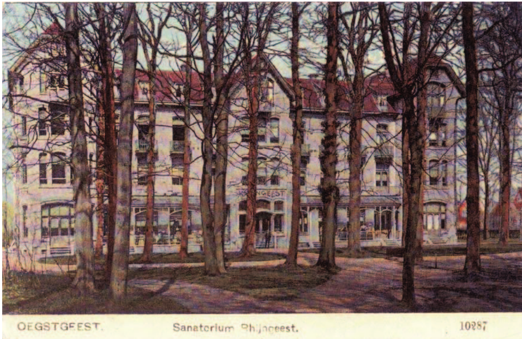
Abb. 149: 1902 eröffnetes Sanatorium Rhijngeest, das 1949 in den Besitz der Universität Leiden übergang, 1950 in Jelgersmaklinik umbenannt wurde und 1993 erneut an die Gemeinde Oegstgeest verkauft wurde. Am 5.6.1999 wurde es als Rathaus eröffnet
