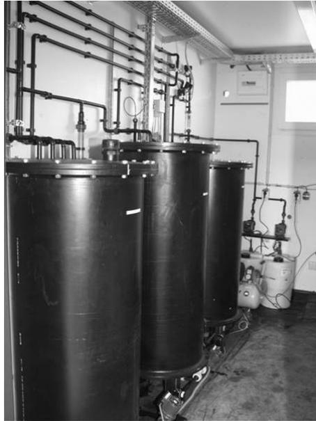
**Abb. 103:** Reaktoren für den Bioabbau in der Modellanlage in Elsnig
