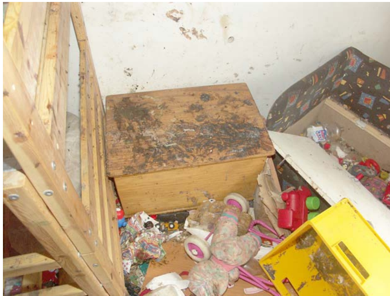
Abb. 17: Kotbeschmiertes, zerstörtes Mobiliar im Kinderzimmer (Sektions Nr. 649-04)
