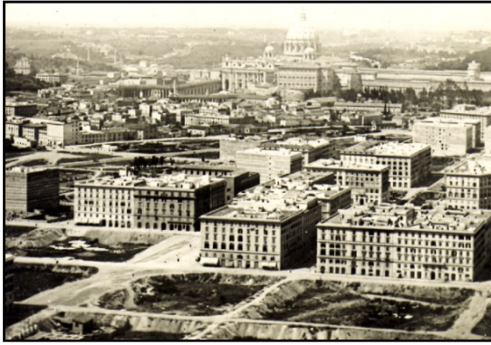
Abbildung 8: Erschließung des neuen Viertels Prati di Castello
