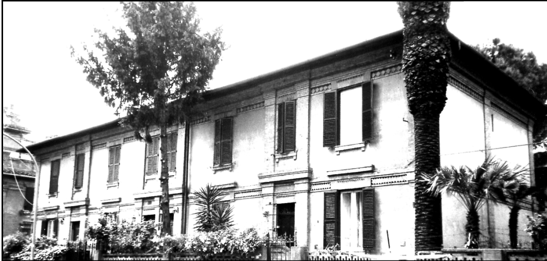
Abbildung 12: Ein- Zweifamilienhaustyp des öffentlich geförderten Wohnungsbaus (hier in der Siedlung San Saba)
