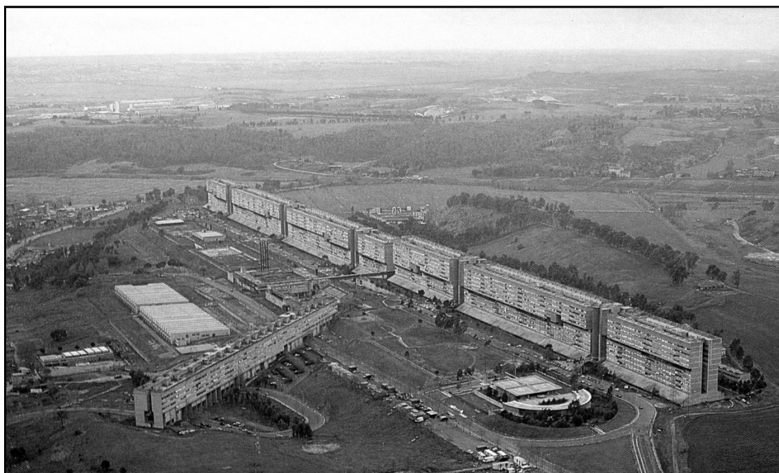
Abbildung 39: Die Großwohnanlage Corviale
