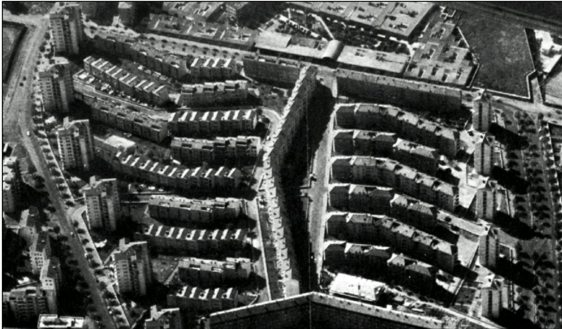
Abbildung 29: Luftansicht der Siedlung Tuscolano 2
