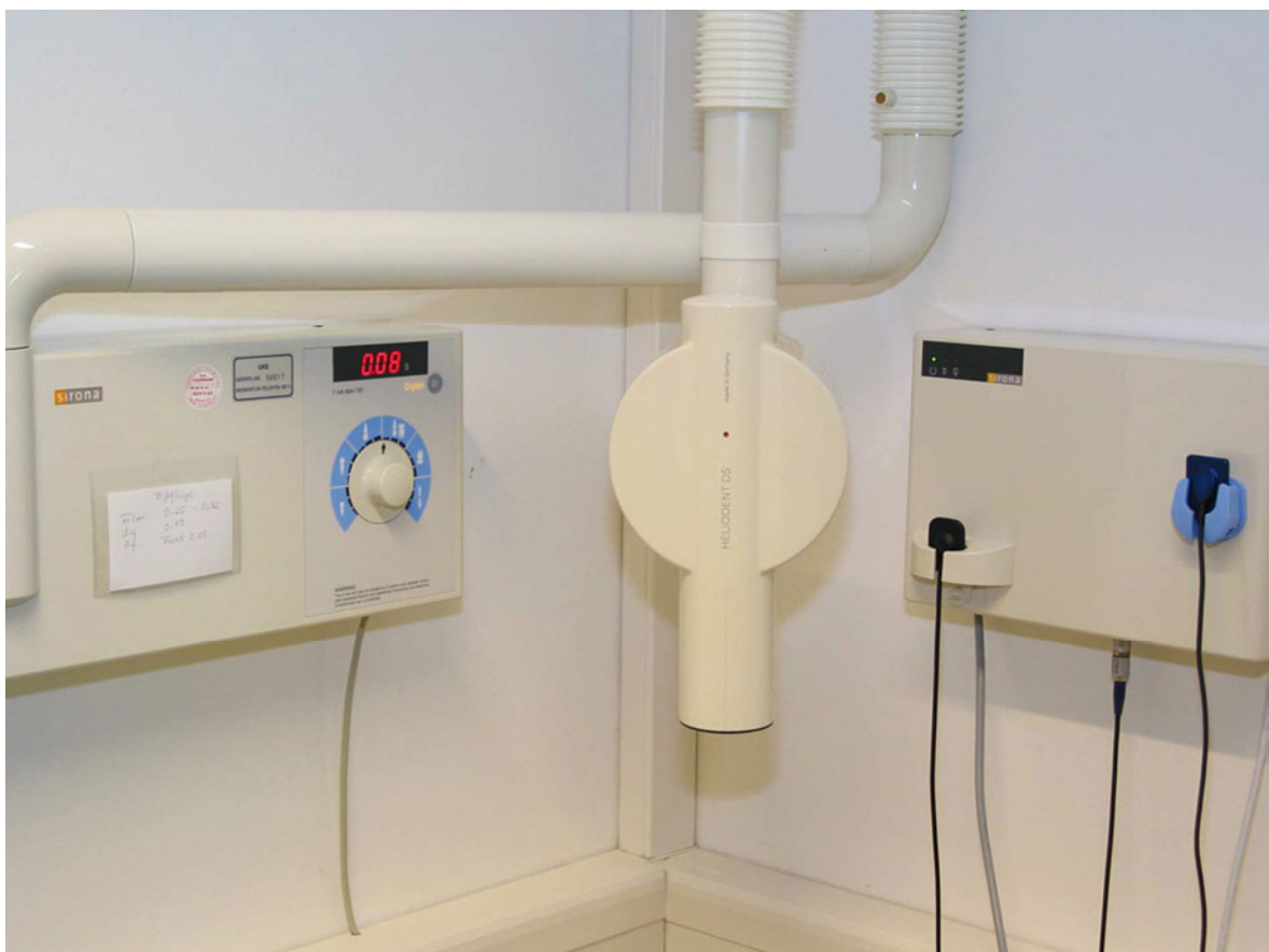
Abb. 14: Röntgenröhre Heliodent DS mit 2 digitalen Röntgensensoren (Sidexis und XIOS)
