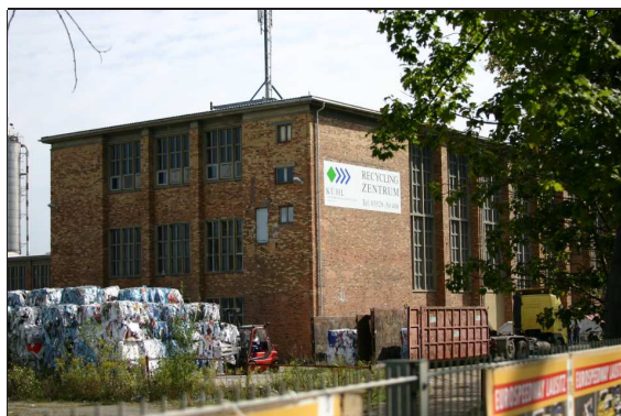
Abbildung 3.6: Recyclinganlage im Industriegebiet Heidenau
