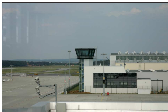
Abbildung 3.4: Blick auf eine Landebahn und Flughafengebäude des Flughafens Dresden-Klotzsche
