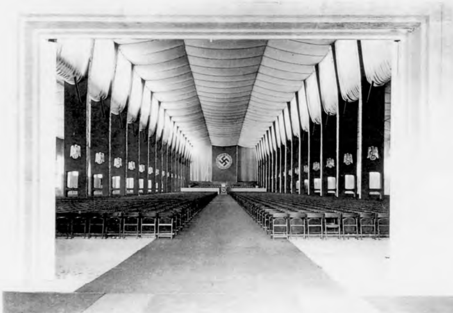
133 Innenansicht der Luitpoldhalle, die für die Reichsparteitage mit Stoffen ausgeschlagen wurde, um das Oberlicht zu dämpfen (Ausst. Kat. Kulissen der Gewalt 1992, S. 57)
