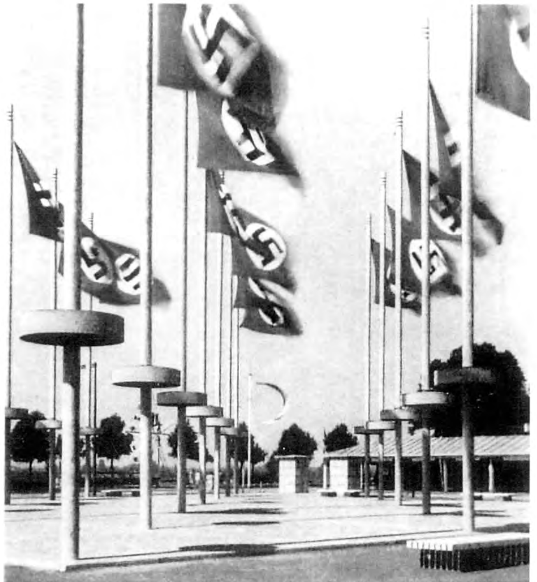
341 Integrierte Lichttechnik. Ausstellung 'Schaffendes Volk' 1937. Bildunterschrift: "Zylindrische Fahnenmaste mit Betonschale zur Aufnahme von Scheinwerfern für die nächtliche Flaggenbeleuchtung. Schaft gestockt, Schale scharriert" ( Beilage zum Baumeister 9/Sept. 1937, S. 1241)
