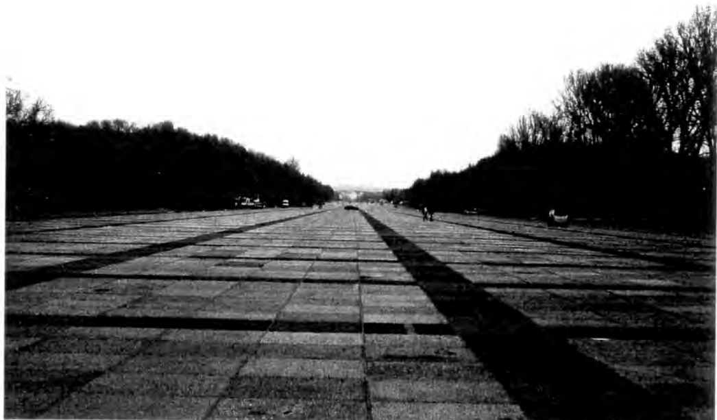
64 'Die Straße des Führers', Reichsparteitagsgelände Nürnberg. Hier ist dasselbe Muster wie bei der Reichskanzlei verwendet worden, nur in umgekehrter Form (F. Livings 1998)
