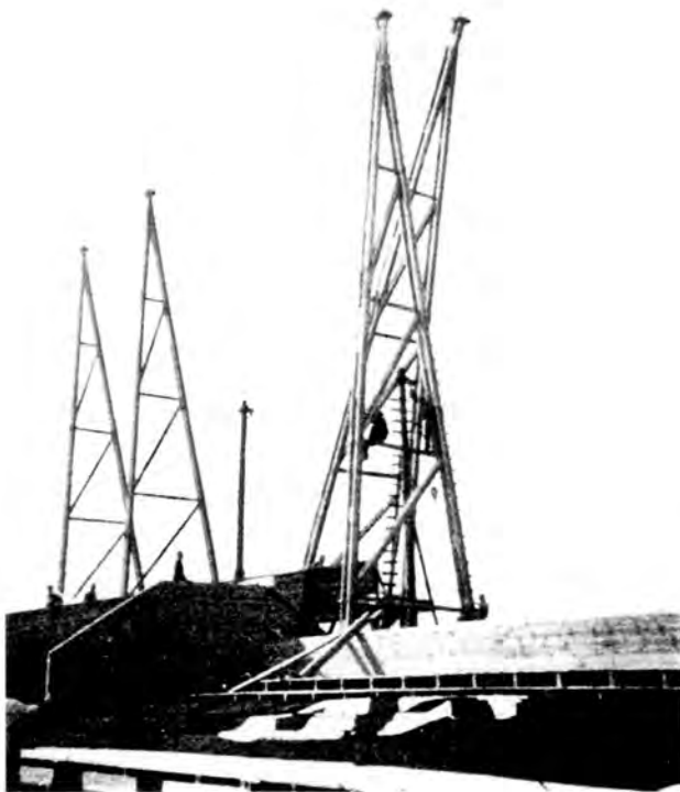
43 Das Aufrichten der Hauptfahnenmasten mit Spannseilen, 1933 ( ZdB 21/17. Mai 1933, S. 248)
