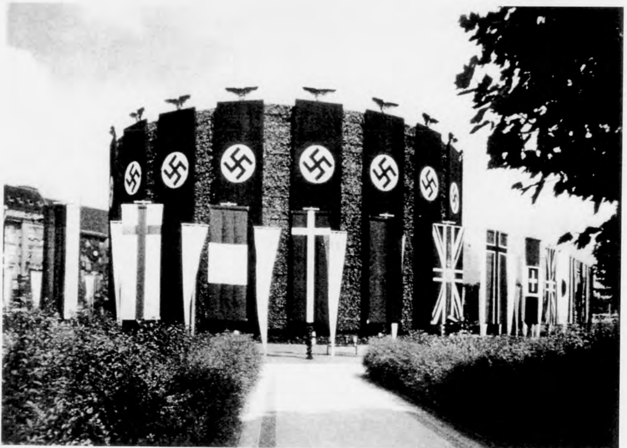
174 Leo Lottemoser, Fahnenturm 1936. Ansicht von der Ringstraße des Pariser Platzes aus (Weidner 1940, S. 150)
