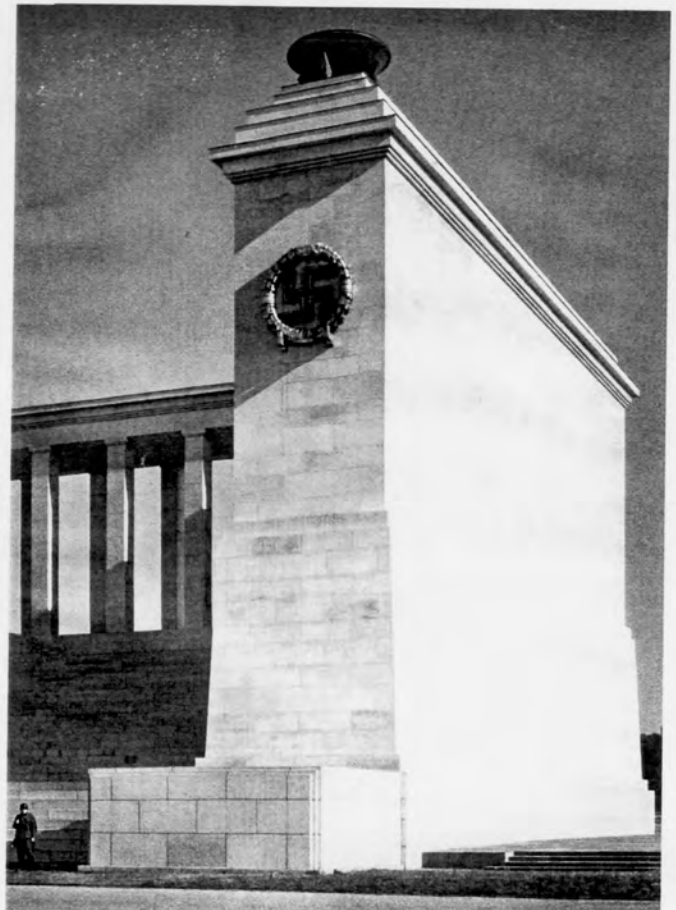
145 Rechte Eckbastion der Zeppelintribüne mit umkränzttem Hakenkreuz und bekrönender Flammenschale ( Wolters 1943, S. 23)
