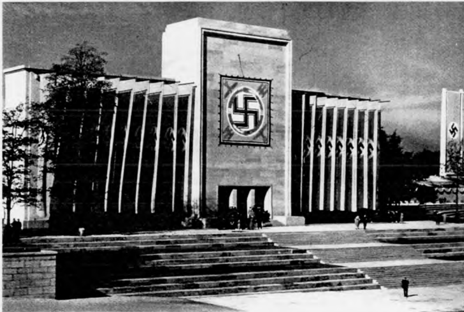
132 Die Luitpoldhalle mit quaderverkleideter Schauffront und lamellenartigen Fahnen (Wolters 1943, S. 18)
