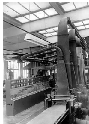
Abbildung 8 Versuchsdefibrator (links) und Vliesbildungsanlage zur kontinuierlichen Faservliesbildung (rechts) im IHD /Kehr 2006/
