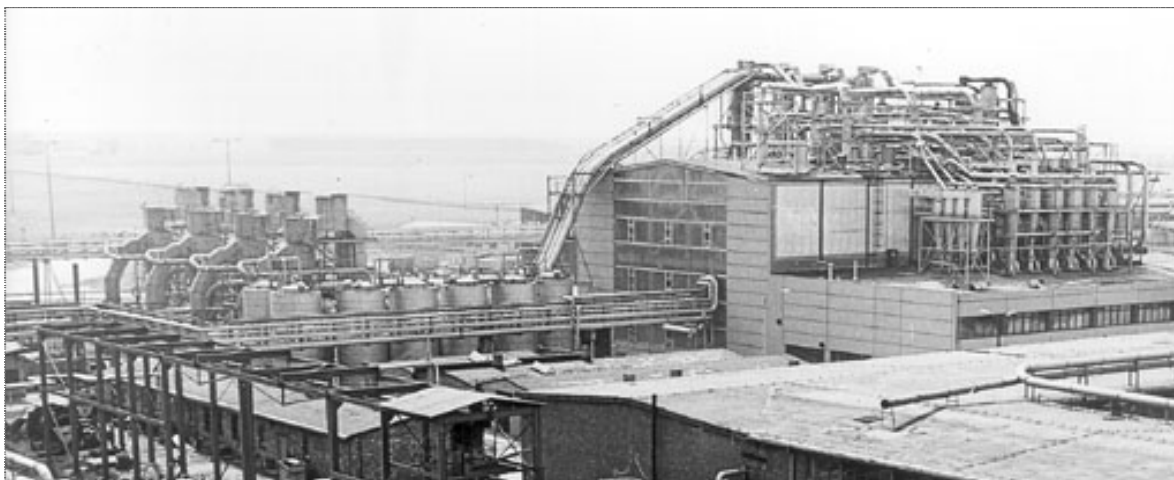
Abbildung 7 Teilansicht der MDF-Anlage im VEB Faserplattenwerk Ribnitz-Damgarten im Jahr 1973 – links hinten im Bild vier Düsenrohtrockner mit nachgeschalteten Rotationsfiltern, rechts oben Produktionshauptgebäude mit Abscheidern für 4-Linienbetrieb (Deckschicht, Zwischenschicht, 2x Mittelschicht), ganz rechts Abscheider für Faserfließbildung, Foto IHD
