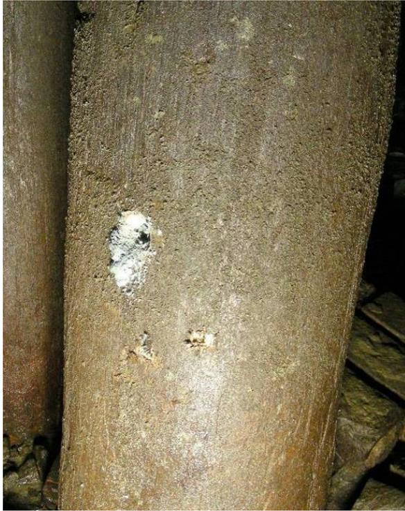
**Abb. 16: Gründungspfahl einer Lagerhalle im Hamburger Hafen (Tidezone). Heller Bereich: Bohrloch der Probenentnahme zur mikroskopischen Untersuchung des Gewebes.**
