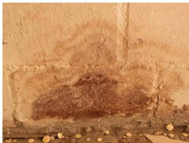
**Abb. 4: Durchfeuchtete Außenwand einer Schießbahn, bewachsen mit *Asterostroma cervicolor*.**
