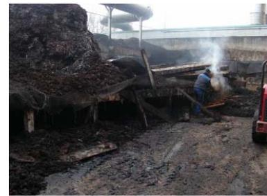
**Abb. 5: Kompostwerk, die Unterkonstruktion eines Biofilters (*Lophira alata*), wurde durch Moderfäulepilze zerstört.**
