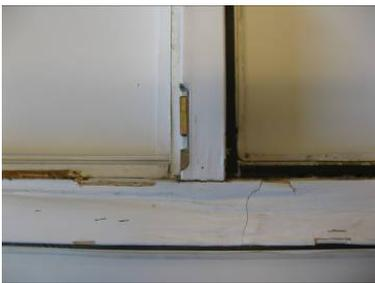
**Abb. 3: Holzfenster (*Shorea* spp.) mit massivem Weißfäulebefall (*Phellinus* spp.).**
