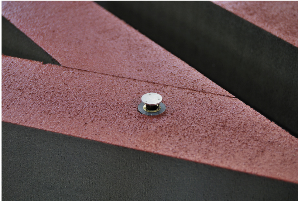
Abbildung 5-9: Einbau der Punktquelle auf dem Dach eines Gebäuderings in Michel-Stadt.
