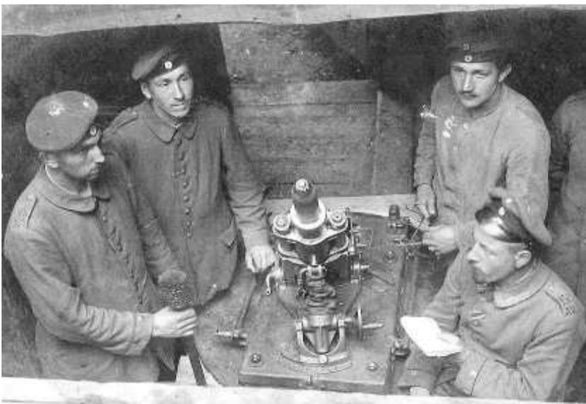
Abb. A1.18.: 7,585 cm leichter Minenwerfer a.A., Ansicht von oben auf die rechteckige Grundplatte. Die Mine befindet sich nicht vollständig in Ladestellung, Quelle: Archiv des Verfassers ©
