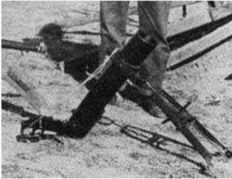
Abb. A3.4.: glatter 4 inch Grabenwerfer mit Zweibeinunterstützung,
