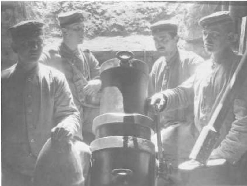
Abb. A1.91.: Minenwerfer Voith, mit Geschoss und Ansetzter (rechts),
