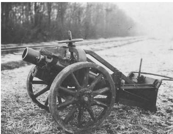
Abb. A1.25.: leichter Minenwerfer in Flachfeuerschießgestell,
