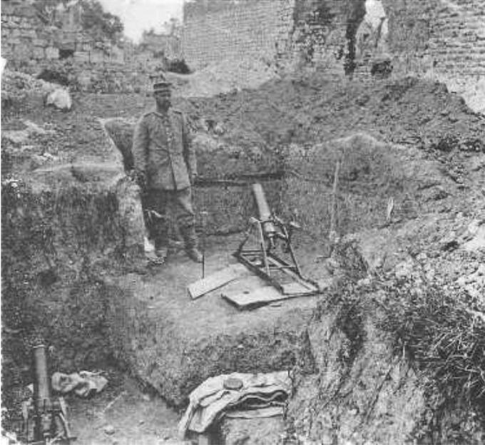
Abb. A1.53.: zwei 9 cm glatte Minenwerfer (Lanz) in Stellung, man beachte die Grundplatte ohne Holzverstärkung sowie das Zubehör auf der Zeltbahn im Vordergrund,
