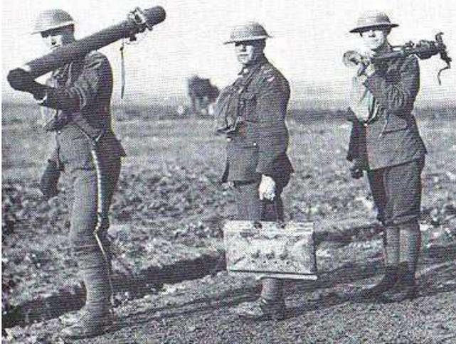
Abb. 5.33.: Stokes 3 in Werfertrupp, man beachte die Grundplatte mit den 3 Aufnahmen für das Rohr in Hinteransicht (Mitte),
