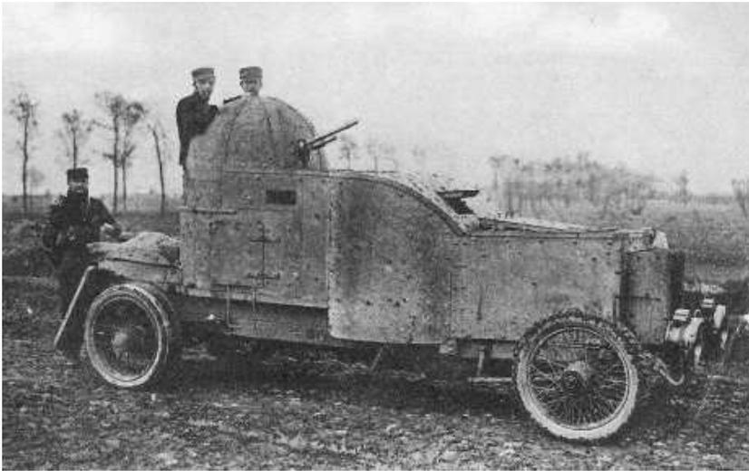
Abb. 5.8.: belgischer Radpanzer in Dixmuid 1914, (Bildpostkarte), man beachte den Drehturm für MG,
