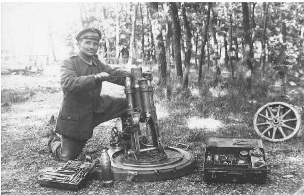
Abb. A1.22.: 7,585 cm leichter Minenwerfer n.A., mit Waffenmeisterwerkzeugen, sowie Granate und abgenommenem Holzspeichenrad (Hintergrund),
