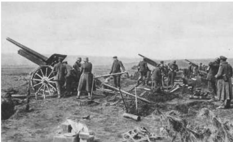
Abb. 5.5.: deutsche 10 cm Artillerie (10 cm K 17 L/45), man beachte die langen Rohre und die Rohrerhöhung, die eine hohe Reichweite ermöglichten,
