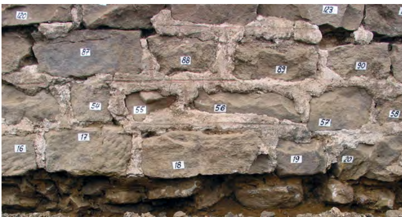
Abb. 110 - Putz mit rotem Fugenstrich an der Mauer des Nordpodiums
