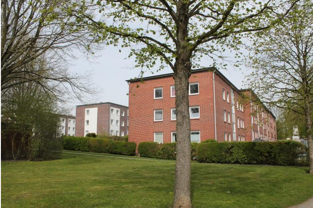
Abbildung 170: Prozess der Verkleidung mit Wärmedämmung im Harnackring am 17.4.2014
