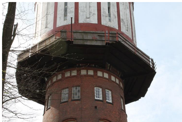
Abbildung 49: Wasserturm "Sander Dickkopp" mit Holzrahmen als Schutz vor herabfallenden Steinen am 17.4.2014
