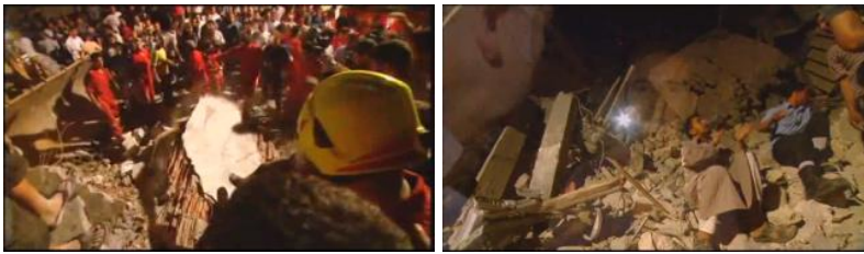
Abbildung 167: News, 19.6. Zerstörtes Wohnhaus.
