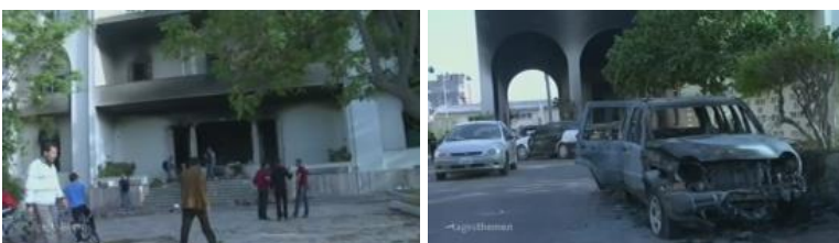
Abbildung 176: Tagesthemen am 1.5. Zerstörtes Gebäude und zerstörtes Auto.
