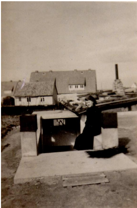
Abbildung 6: Frau B. in der Siedlung Neu Wulmstorf vor ihrem Kellerabgang. Der Rest des Hauses ist noch nicht fertiggestellt. Der Kontrast des Wohnens wird durch das im Bildhintergrund bereits fertiggestellte Haus mit Stall visualisiert.
