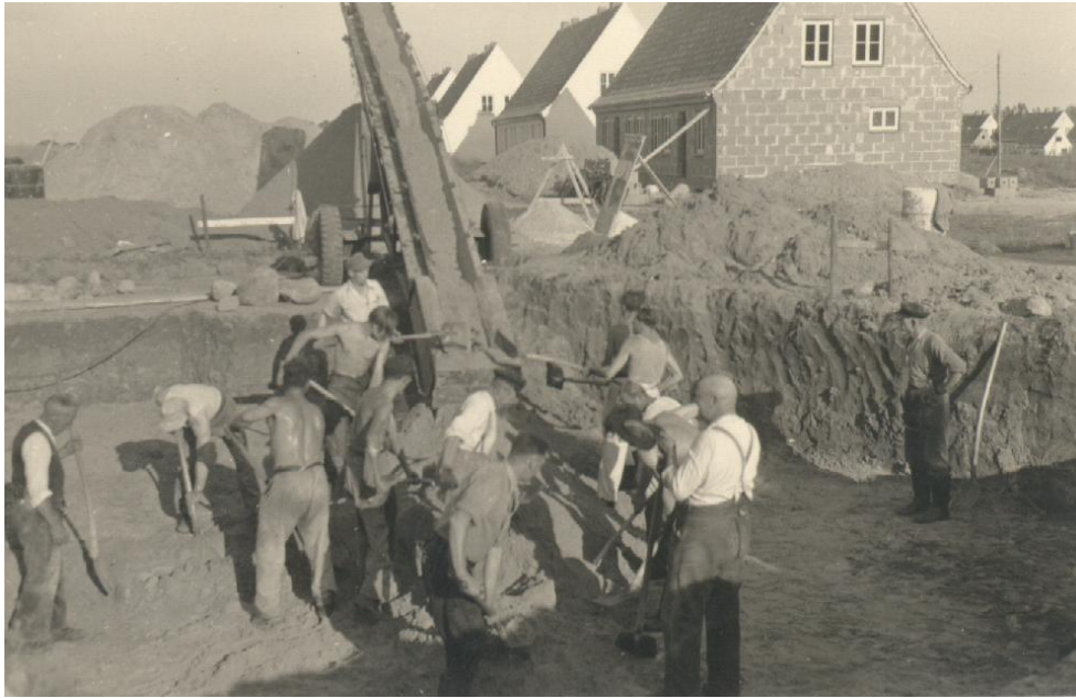
Abbildung 10: Siedler beim Ausheben eines Kellers in der Siedlung Emmelndorf. Im Bildhintergrund sind bereits fertiggestellte Häuser zu erkennen.
