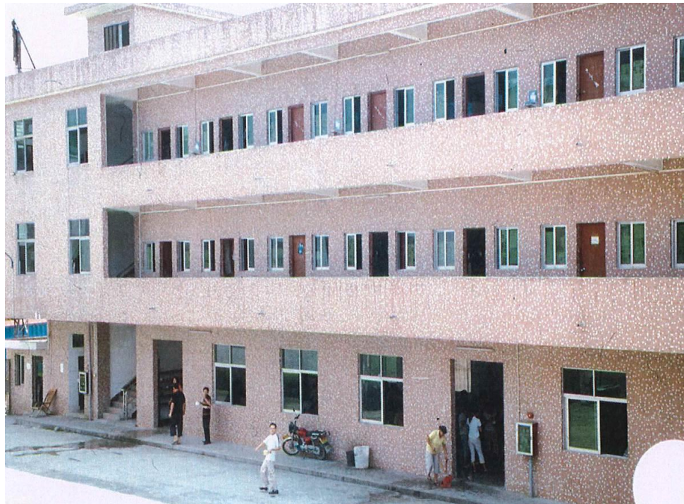
Abb.37: Firmeninterne Wohnanlage + Kantine (im Erdgeschoss) - Huabao zhiyi 华宝制衣 ( Wah Po Factory ) (Privataufnahme 2010)
