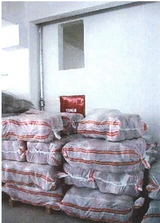
Abb.34: Blockierte Brandbekämpfungseinrichtung (Privataufnahme mit freundlicher Genehmigung von Esther Tse, 2009)
