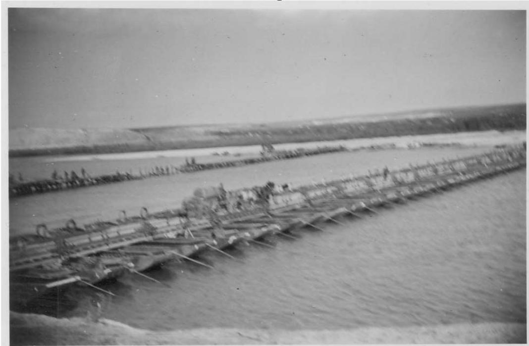
Auf diesem Photo ist deutlich zu erkennen, welche Leistungen von den Pionieren zu erbringen waren, um eine improvisierte Brücke des breiten Stroms Don zu bauen, die auch schweren Fahrzeugen standhalten musste. Sie besteht aus vielen, mit einander verbundenen und im Flussbett verankerten Pontons, über die eine „Straße“ aus Holzbohlen gebaut und befestigt wurde.
