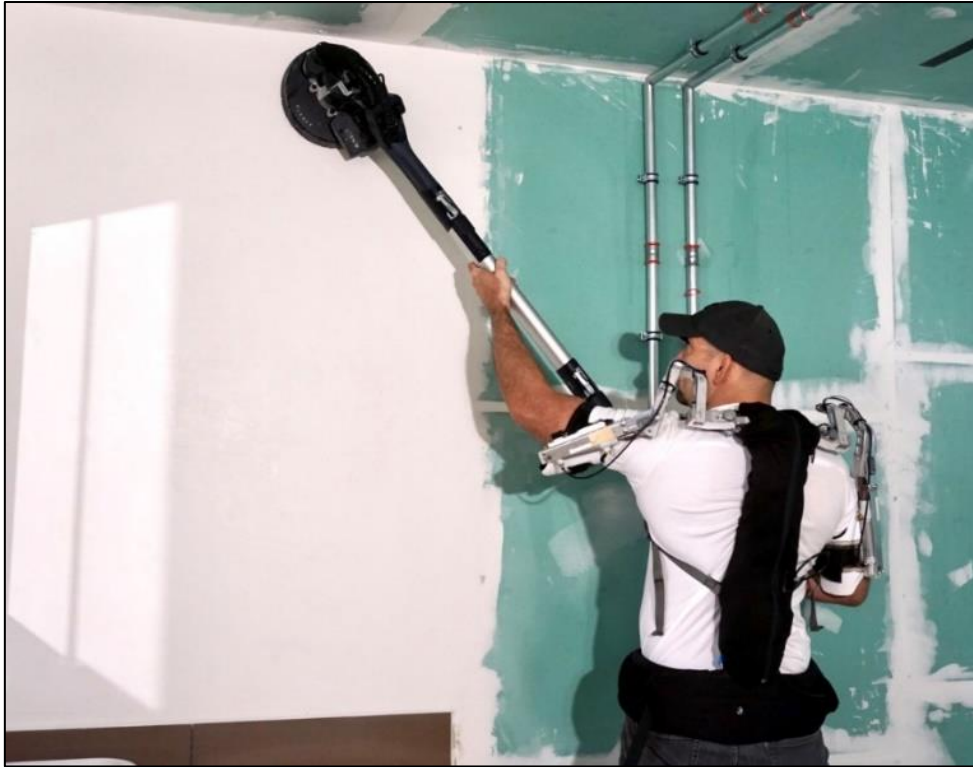
Abb. 18 Exoskelett Lucy 2.0 in einem Feldtest mit Langhalsschleifer im Rohbau (nachgestellt)
